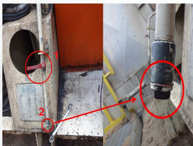
Figura 13: Inspeção – Verificação do dreno.
