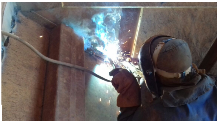
Figura 09: Operador dentro da carreta fazendo manutenção.
