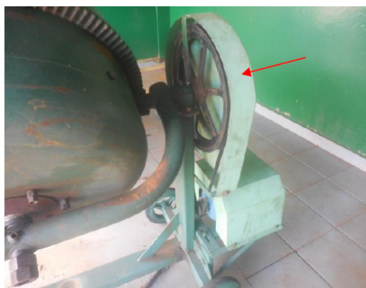
Figura 11: Proteção de acionamento da betoneira (inadequado).
