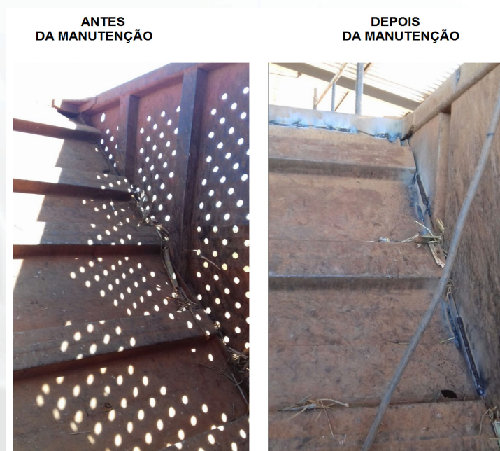
Figura 10: Antes e depois da manutenção.
