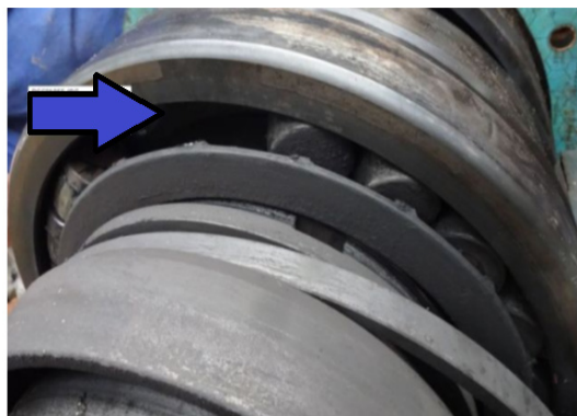
Figura 10: Inspeção – Gaiola Rompida.
