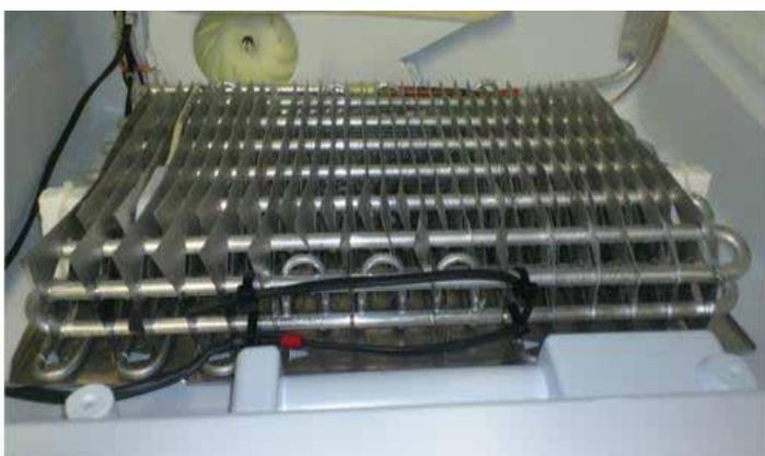
**Fig. 23** – Aplicando a nova resistência de degelo.
