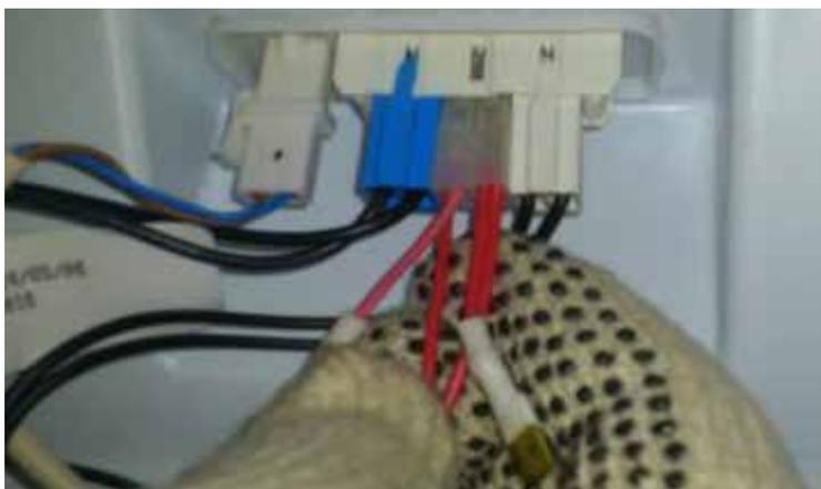
**Fig. 20** – Aplicando a nova resistência de degelo.
