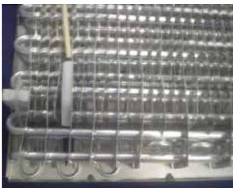
**Fig. 12** – vista de um sensor de degelo.
