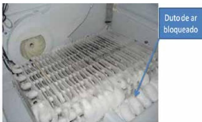
Fig. 17 – bloqueio de gelo no evaporador.
